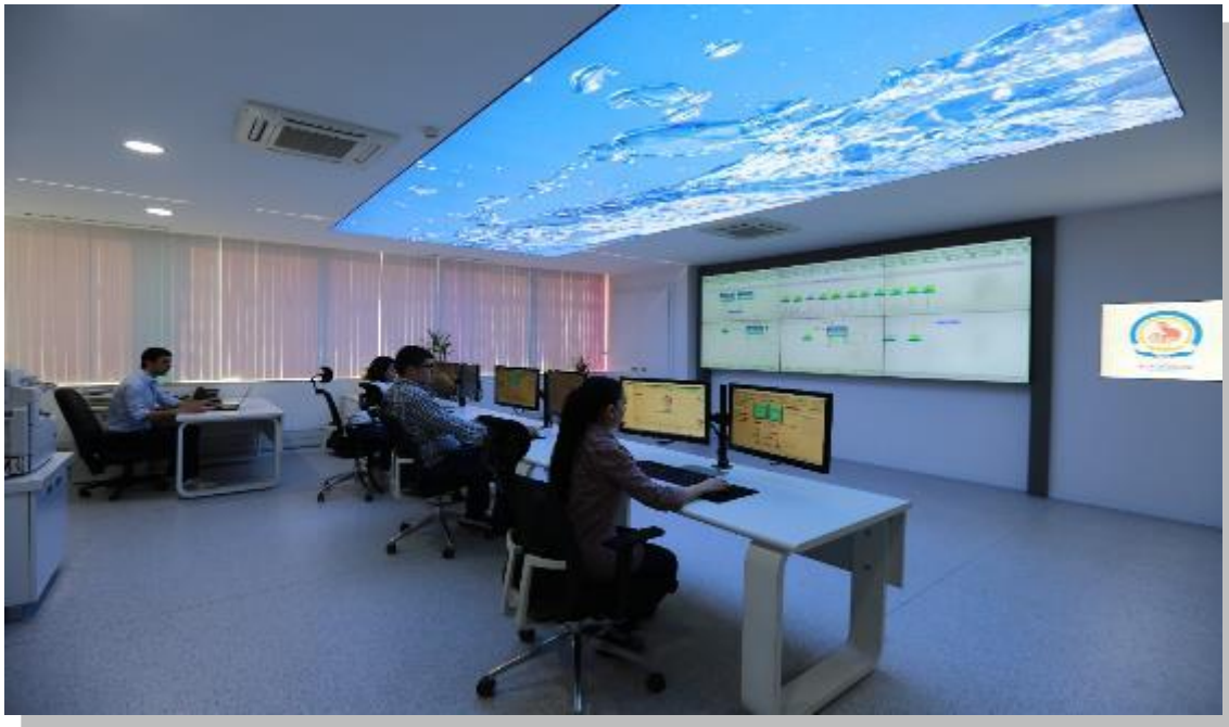
Şekil 5.1. DESKİ SCADA İzleme Merkezi
