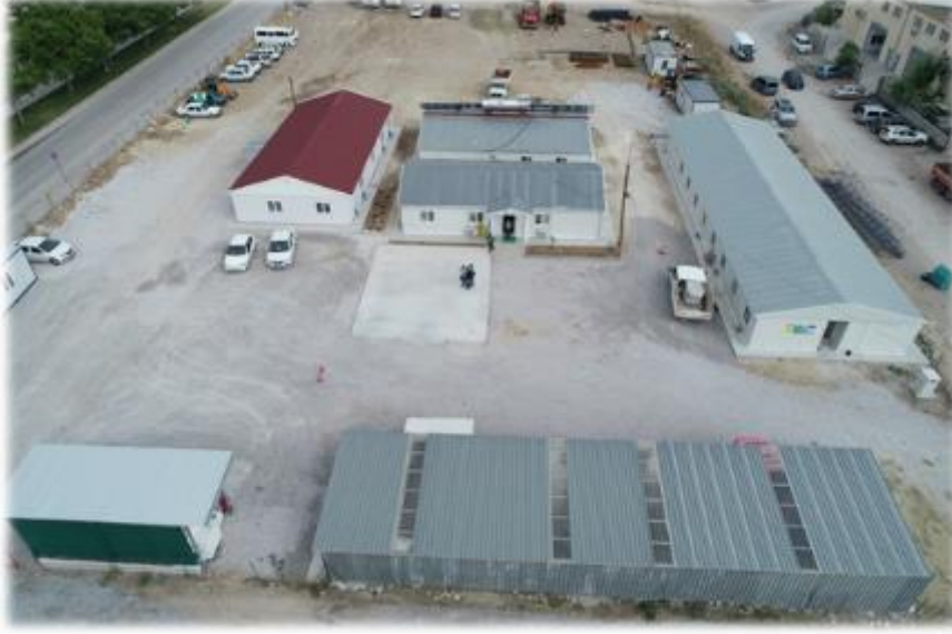
Şekil 3.2. DES-W2 Şantiye Alanı
