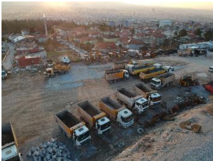
Şekil 3.1. DES-W1 Şantiye Alanı
